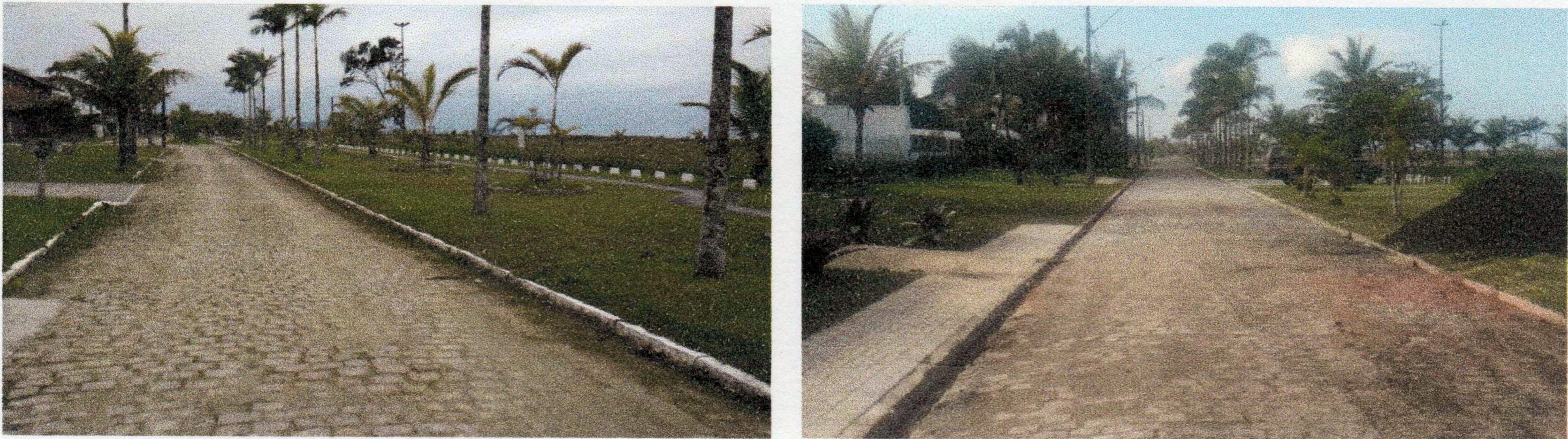
Rua Beira Mar: reconstrução
